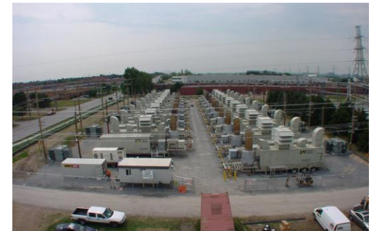
15 Solar Mars units for Standby, Toronto, 2003
